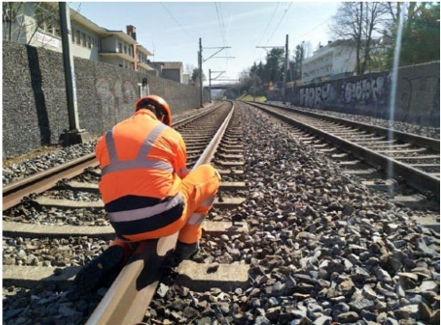
*In Rüschtikon betreut Keller + Steiner ein Gleismonitoring-Projekt mit 109 Überwachungspunkten. Diverse Berechnungen zur Verwindung und Neigung sind im Projekt selbstverständlich inkludiert.*
