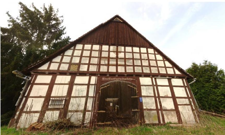
Bilder aus dem Scanner zeigen die Vorderansicht der ehemaligen Gaststätte. In Summe 147 Standpunkte wurden für die vollständige Aufnahme des Objektes gewählt.
