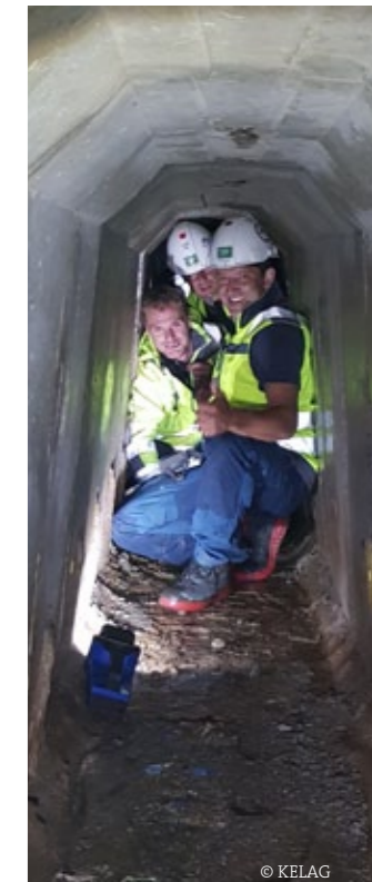
Wolfgang Winkler von der KELAG gibt interessante Einblicke in die Stollenvermessung beim Speicher Wurtenboden.
