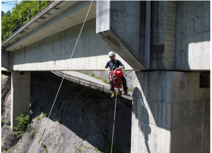
Der Autor beim Installieren von Monitoringzielen an einer Eisenbahnbrücke.
