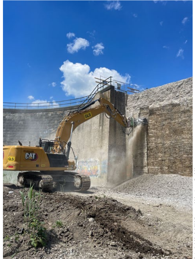
Der Abtrag des schadhafte Betons wird durch präzise Vermessungen laufend kontrolliert.
