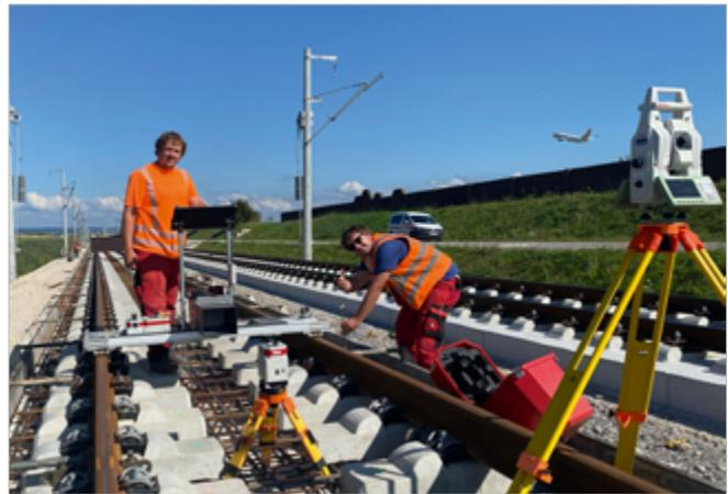
Damit alles rund läuft, wird jede Schwelle entlang der Schnellfahrstrecke Stuttgart – Ulm auf einen halben Millimeter feingerichtet und dann zu einer Festen Fahrbahn einbetoniert.
