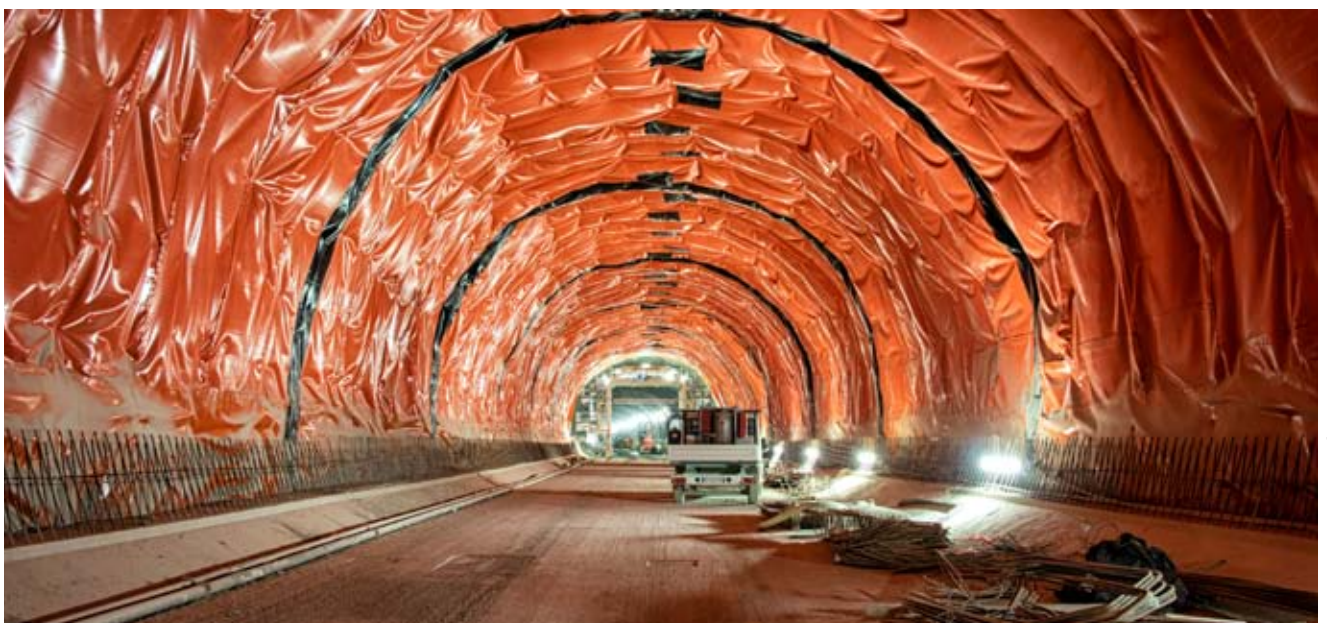
Der Brenner Basistunnel wird zum Zeitpunkt der Fertigstellung mit 64 km die längste unterirdische Eisenbahnverbindung der Welt sein. Hier: Die Eisackunterführung mit PVC-Abdichtung
