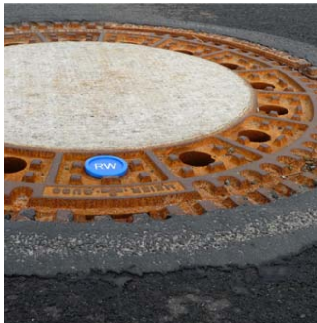
RFID-Transponder an einem Kanaldeckel für das Kennzeichnen und Speichern von Informationen zur Infrastruktur.
