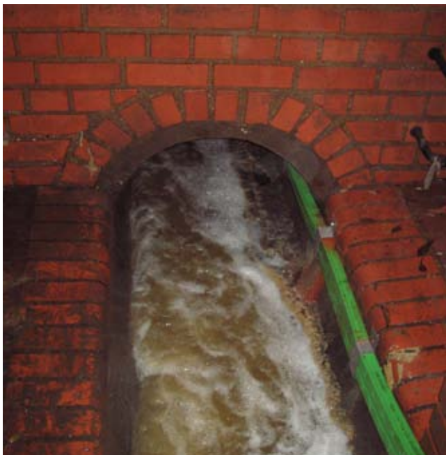
Bei CableRunner werden u.a. Abwasser-Kanäle mit Glasfaserleitungen ausgestattet.
