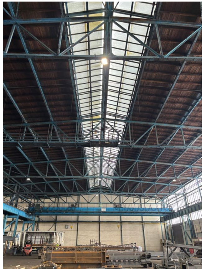
Die Halle wurde mit dem 3D-Laserscanner aufgenommen, die Punktwolke für weitere Planungen in rmDATA Reality3D ausgewertet.
